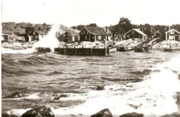
Bild från 40-talet som visar bålverket vid storm – en vågbrytare som skyddar bryggorna och husen från att förstöras av vågorna. Jämför bilden med den ovanför. Bild från Frank Carlberg.
