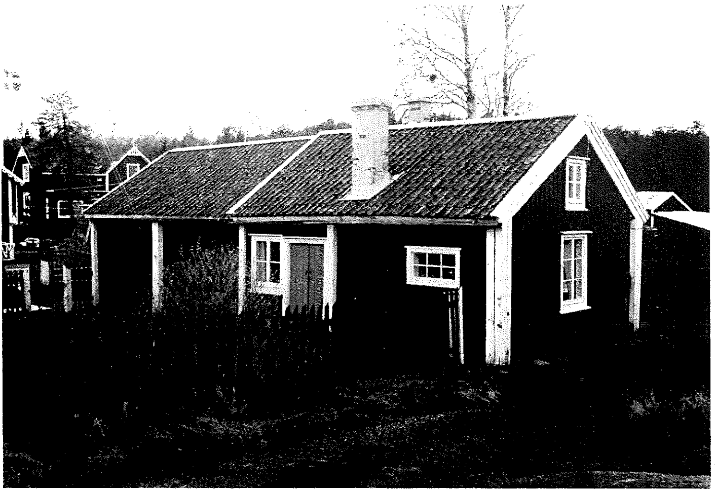
Ett tegeltak har liv. Bilden på huset med tak av enkupiga tegelpannor togs på 60-talet.
