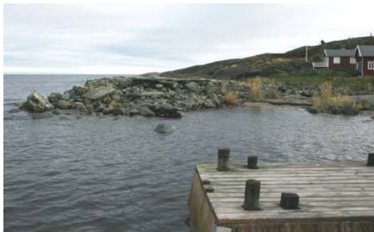
Resterna av vågbrytaren/bålverket som skyddade bryggor och hus mot stormvågorna.
